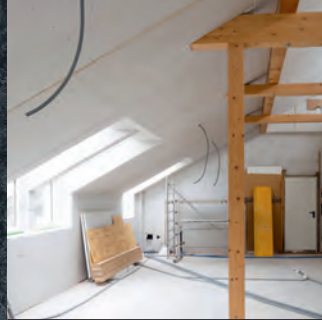
Trockenbau und Bauelemente
