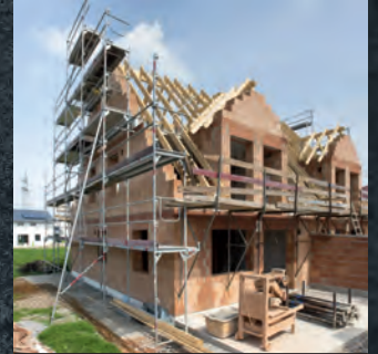
Roh- und Hochbau
