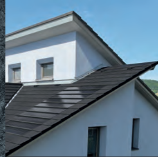
Dach und Fassade
